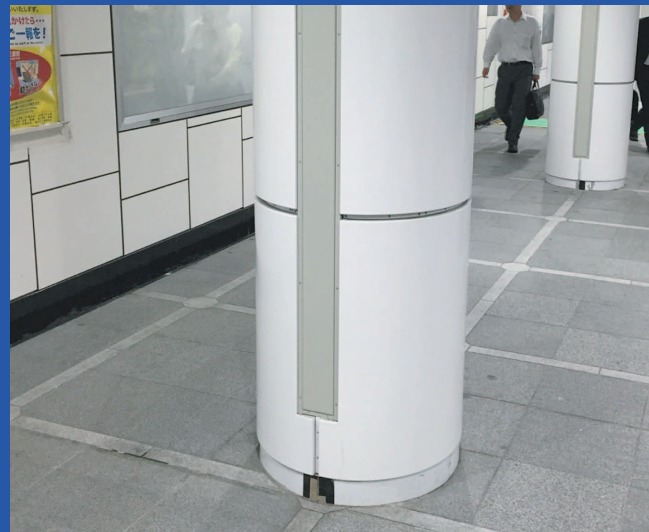
地下鉄構内内壁建材 (汚れ防止・傷防止)
