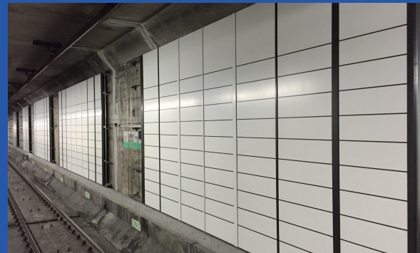
地下鉄構内内壁建材 (汚れ防止・傷防止)
